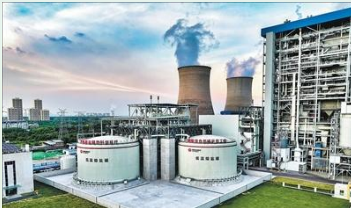
国家能源集团安徽公司宿州电厂熔盐储能项目现场
