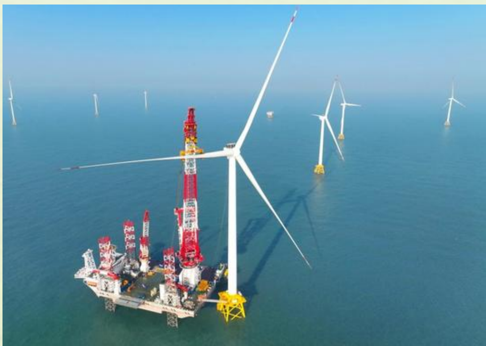
1月13日在福建闽南海域拍摄的“大桥海风”号2000吨自升式海上风电安装平台和20兆瓦风电机组吊装现场
